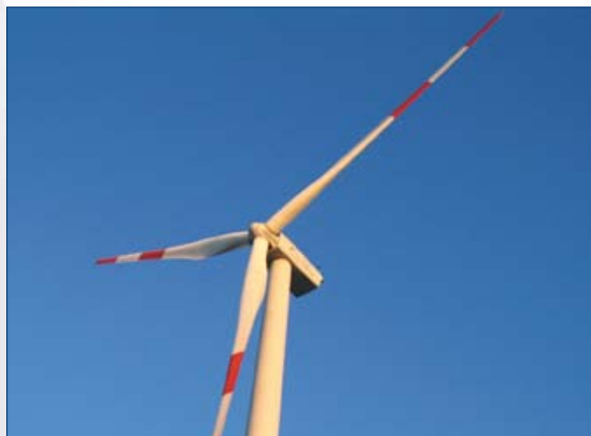
Windkraftanlage · Wind turbine
