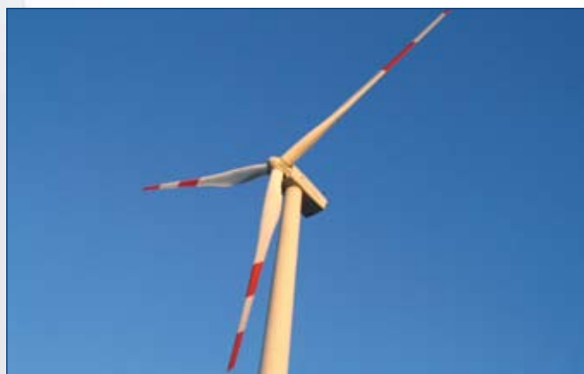
Windkraftanlage · Wind turbine
